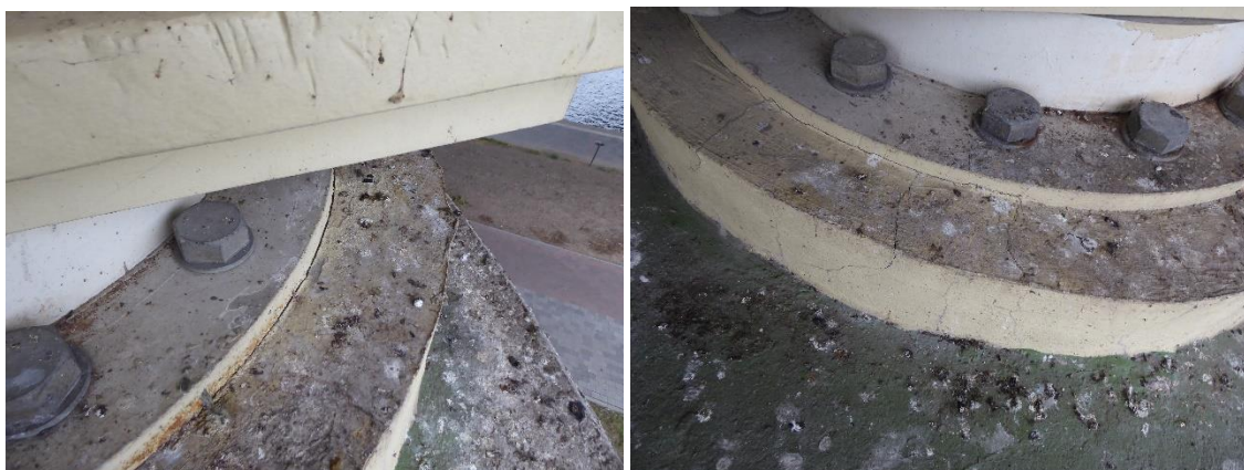
Rys. 8.4. Oznaki przeciążenia łożyska stałego od strony PKS
