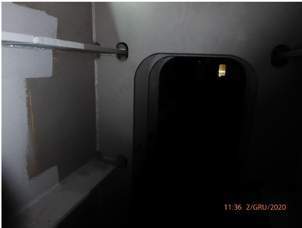
Rys. 8.2. Konstrukcja wewnątrz skrzynek mostu. Poprawki malarskie
