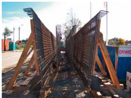
Fot. 2. | Realizacja obiektu WA22' na AOW metodą „przęsło po przęśle” (projekt – Mosty Katowice i LAP z Norymbergi; realizacja – DYWIDAG Bau GmbH)
