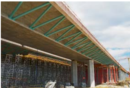
Fot. 3. | Budowa estakad WA17 (nasuwanie podłużne) i WA19 (rusztowania inwentaryzowane) w ciągu AOW. Projekt WA17 – ZB-P MOSTY-WROCŁAW i LAP z Norymbergi, realizacja – DYWIDAG Bau GmbH; projekt WA19 – ZB-P MOSTY-WROCŁAW, realizacja – STRABAG
