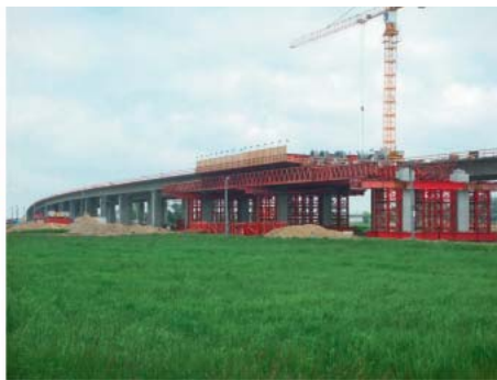
Fot. 2. | Realizacja obiektu WA22' na AOW metodą „przęsło po przęśle” (projekt – Mosty Katowice i LAP z Norymbergi; realizacja – DYWIDAG Bau GmbH)
