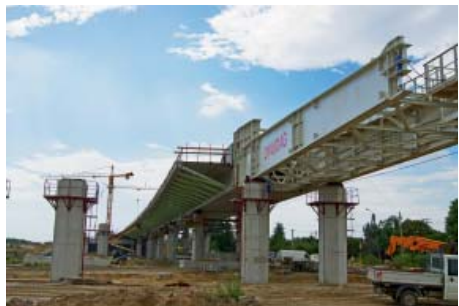
Fot. 3. | Budowa estakad WA17 (nasuwanie podłużne) i WA19 (rusztowania inwentaryzowane) w ciągu AOW. Projekt WA17 – ZB-P MOSTY-WROCŁAW i LAP z Norymbergi, realizacja – DYWIDAG Bau GmbH; projekt WA19 – ZB-P MOSTY-WROCŁAW, realizacja – STRABAG
