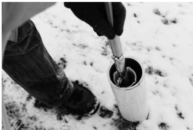
Fot. 3. Wykonanie pomiaru w kolumnie inklinometrycznej (fot. K. Wanik)
