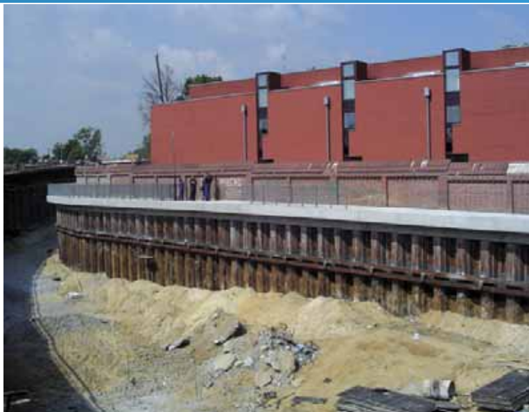
Fot. 5. Trwałe kotwy gruntowe – Trasa Galicyjska
