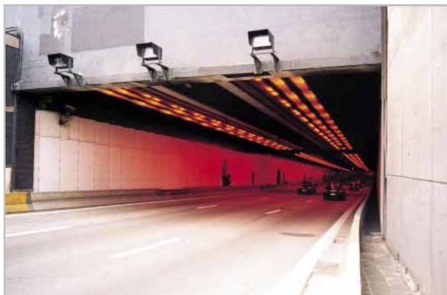
Fot. 5. Tunel Kennedy w Antwerpii – wewnątrz tunelu
