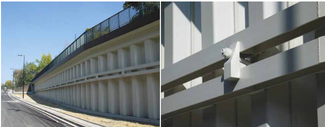
Rys. 5. Ściana oporowa stała z grodzic stalowych wykonana w ciągu ulicy Wita Stwosza w Krakowie (konstrukcja kotwiona w gruncie): a) Widok ściany na wysokości siedziby rozgłośni radiowej „Wanda”, b) Szczegół połączenia kotwy gruntowej z kleszczami.
