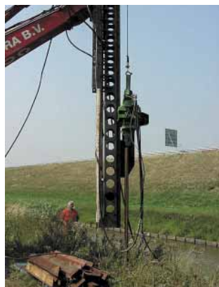
Fot. Kafar do zabijania ścianki szczelnej
