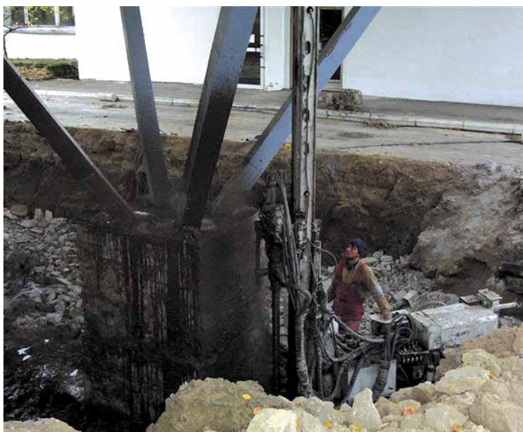
Fot. 4. Podchwycenie istniejących fundamentów mikropalami, Bielsko – Biała
