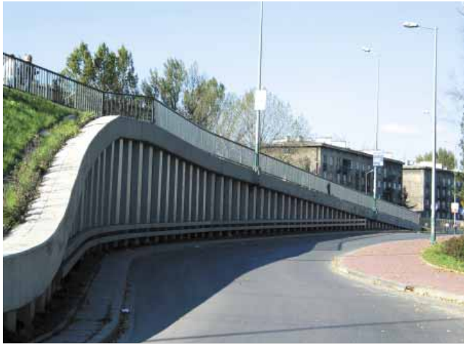
Rys. 6. Ściana oporowa stała z grodzic stalowych przy najeździe na most Kotlarski w Krakowie (konstrukcja ściany w układzie wspornikowym, oddana w grudniu 2001 r.).
