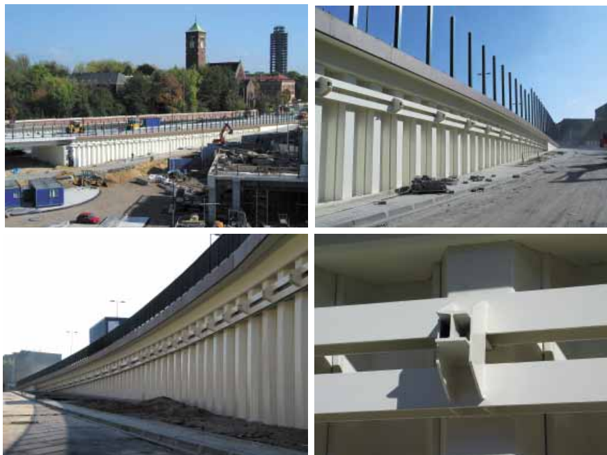
Rys. 4. Najazd na estakadę w ciągu ulicy Wita Stwosza w Krakowie, wykonanej z zastosowaniem konstrukcji ścianowo-ściągowej, z wykorzystaniem grodzic stalowych: a) Widok ogólny od strony ul. Rakowickiej, b) Ściana szczelna – fragment południowy, c) Ściana szczelna – fragment północny, d) Szczegół zakotwienia ściągu w kleszczach.
