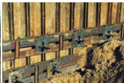
Rys. 2. Tymczasowy układ ścianowo-ściągowy przytrzymujący korpus nasypu kolejowego podczas budowy tunelu drogowego w Krakowie, pod układem torowym stacji kolejowej Łobzów: a) Przekrój poprzeczny konstrukcji tymczasowej, b) c) Widok gotowej ściany szczelnej, d) Szczegóły kotwienia ściąгов rurowych w kleszczach.
