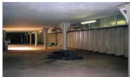
Rys. 3. Parking podziemny w centrum Bristolu, w Anglii, wybudowany w latach 1998-1999, w obudowie stałej z grodzic stalowych: a) Przekrój poprzeczny obiektu w strefie przyściennej, b) Korona ścian szczelnych przygotowana do wykonania wierzchniej płyty stropowej, c) Wnętrze parkingu z widokiem na ścianę szczelną, d) Konstrukcja ściany szczelnej parkingu – widok.
