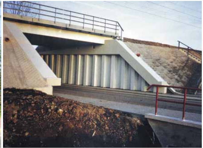
Rys. 7. Przyczółek wiaduktu kolejowego w Lewinie Brzeskim, wykonany z grodzic stalowych [11].
