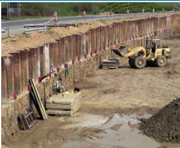
Fot. 2. Trwałe kotwy gruntowe TITAN MONO-JET, Gniezno
