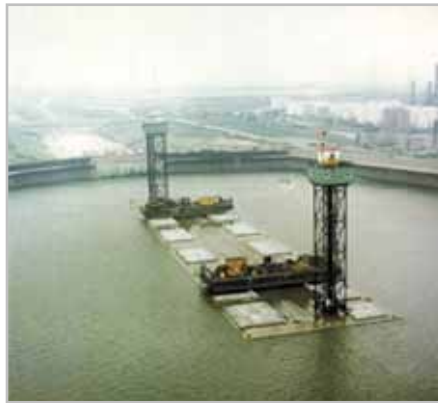
Fot. 2. Zatapiając elementu dołączanego do części lądowej – tunel Liefkenshoek (Hydronomic)
