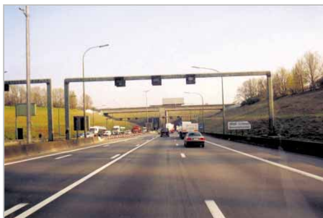
Fot. 6. Tunel Kennedy w Antwerpii – strona północna – widok z samochodu
