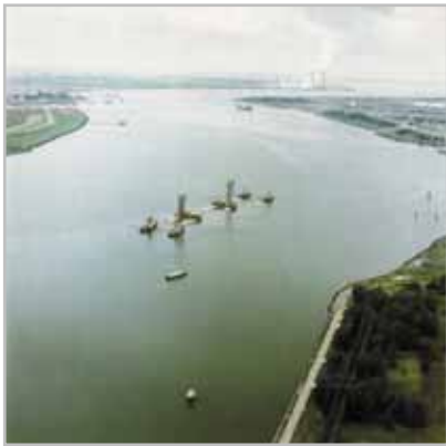
Fot. 1. Splawianie elementu na miejsce zatapiania – tunel Liefkenshoek (Hydronomic)
