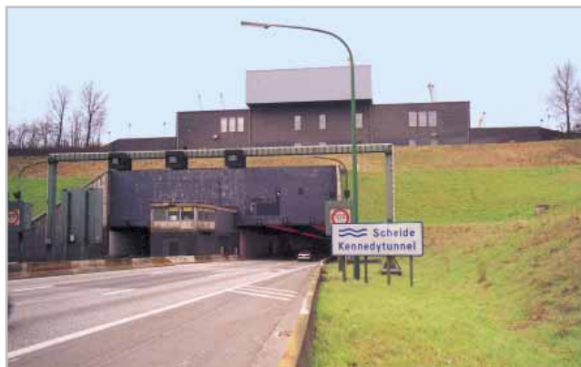
Fot. 4. Tunel Kennedy w Antwerpii – wjazd do tunelu – strona południowa
