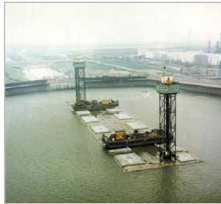
Fot. 2. Zatapianie elementu dołączanego do części lądowej – tunel Liefkenshoek (Hydronamic)
