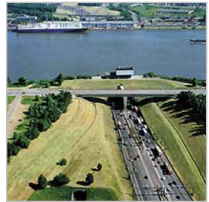
Fot. 3. Tunel Kennedy w Antwerpii – widok z lotu ptaka (Besix)
