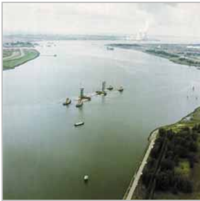
Fot. 1. Splawianie elementu na miejsce zatapiania – tunel Liefkenshoek (Hydronamic)
