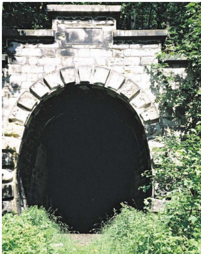
Fot. 3. Tunel pod Małym Wołowcem. Portal od strony Jedliny tor 2
