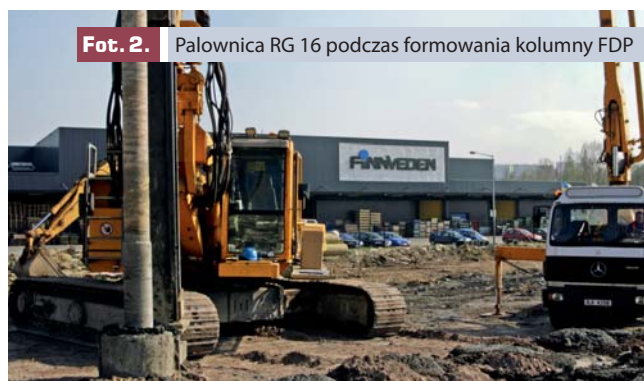
Fot. 3. Formowanie kolumny przemieszczeniowej FDP
