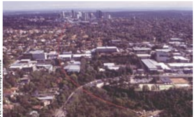
Fot. 3. Budowa grawitacyjnego kanału ściekowego wykonana metodą HDD, Chatswood (obraz przybliżonej trasy przewiertu)
