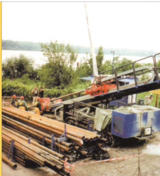
Przewiert sterowany pod rzeką
