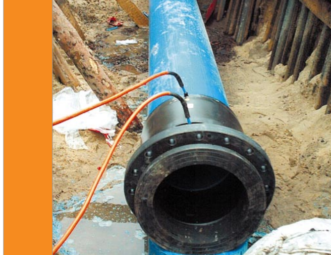
Połączenie kołnierzone
