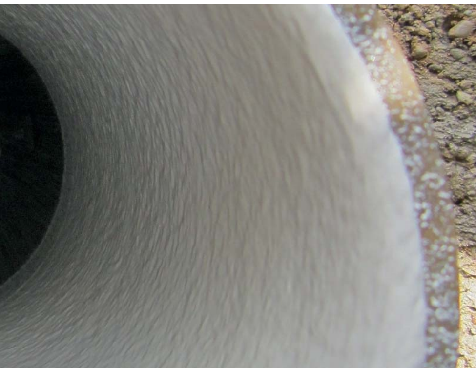
FOT. 3. Inspekcja CCTV po renowacji rurociągu
