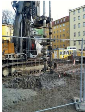
FOT. 2. Wykonawstwo kotew gruntowych i wgłębne wzmocnianie gruntu jako przykłady prac geotechnicznych, w trakcie których może dojść do uszkodzenia przewodów (zdj. autora, prace przy budowie tunelu Blanka w Pradze, prace przygotowawcze dla realizacji budynku wielorodzinnego, Wrocław)
