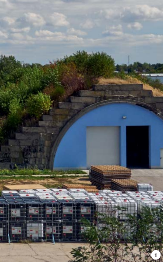
FOT. 1. Widok zakładu produkcyjnego POLiner FOT. 2. Linia produkcji rękawów szklanych UV FOT. 3. Linia produkcji rękawów poliestrowych
