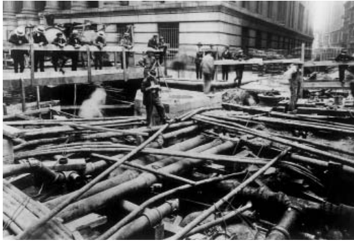
FOT. 1. Nowy Jork, początek XX w. – słynne zdjęcie ukazujące zagęszczenie przewodów infrastruktury podziemnej w skrzyżowaniu ulic (źródło: Consolidated Edison Company of New York, Inc.)
