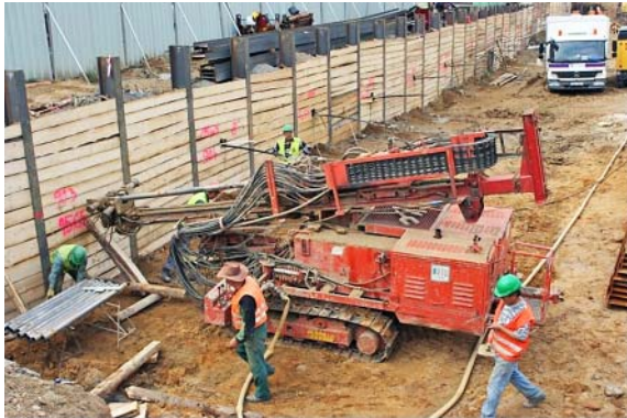
FOT. 2. Wykonawstwo kotew gruntowych i wgłębne wzmocnianie gruntu jako przykłady prac geotechnicznych, w trakcie których może dojść do uszkodzenia przewodów (zdj. autora, prace przy budowie tunelu Blanka w Pradze, prace przygotowawcze dla realizacji budynku wielorodzinnego, Wrocław)
