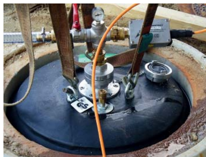
FOT. 7. Pomiar szczelności studni
