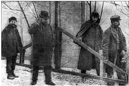
FOT. 3. Historyczne zdjęcie pierwszych prób lokalizowania zakopanych kabli z użyciem cewki elektromagnetycznej nawiniętej na drewnianą ramę [1]
