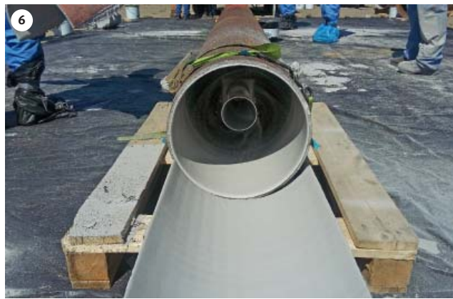
FOT. 4. Rura magistrali stalowej DN300 przed renowacją
