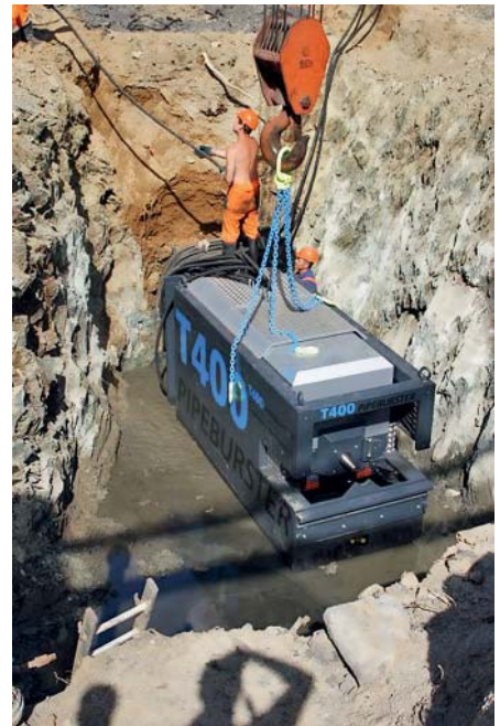
FOT. 5. Zestaw T47 z zasilaczem hydraulicznym, żerdziami roboczymi, głowicą tnącą oraz ciągnącą RYS. 6. Schemat połączeń głowicy roboczej, ciągnącej i rurociągu FOT. 6. Wymiana betonowego rurociągu \varnothing 900\text{mm} na rurę PE \varnothing 1000 w Kanadzie FOT. 7. Pipebuster T400 w wykopie startowym
