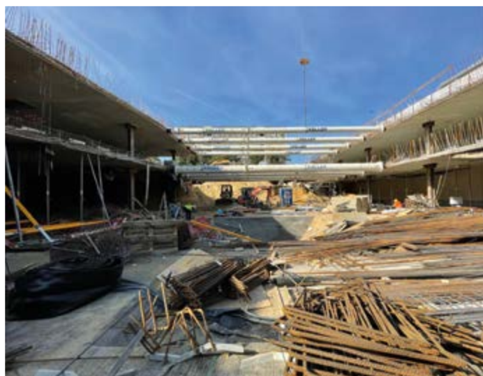
FOT. 4. | Widok centralnej części wykopu z poziomu terenu pierwotnego
