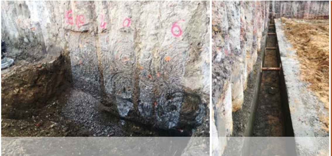
FOT. 2. | Frezowanie palisady przed wykonaniem murków prowadzących FOT. 3. | Wykonane murki prowadzące u podstawy palisady
