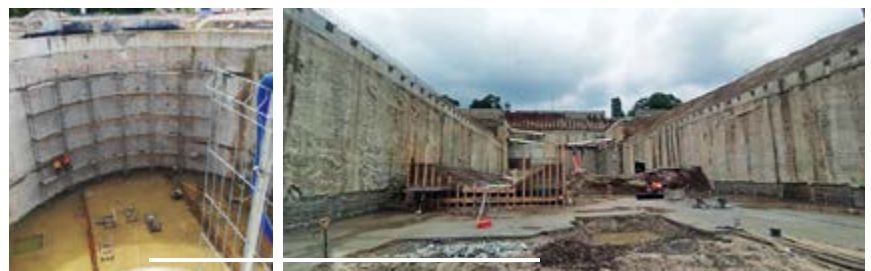
FOT. 1 i 2. | Plac budowy
