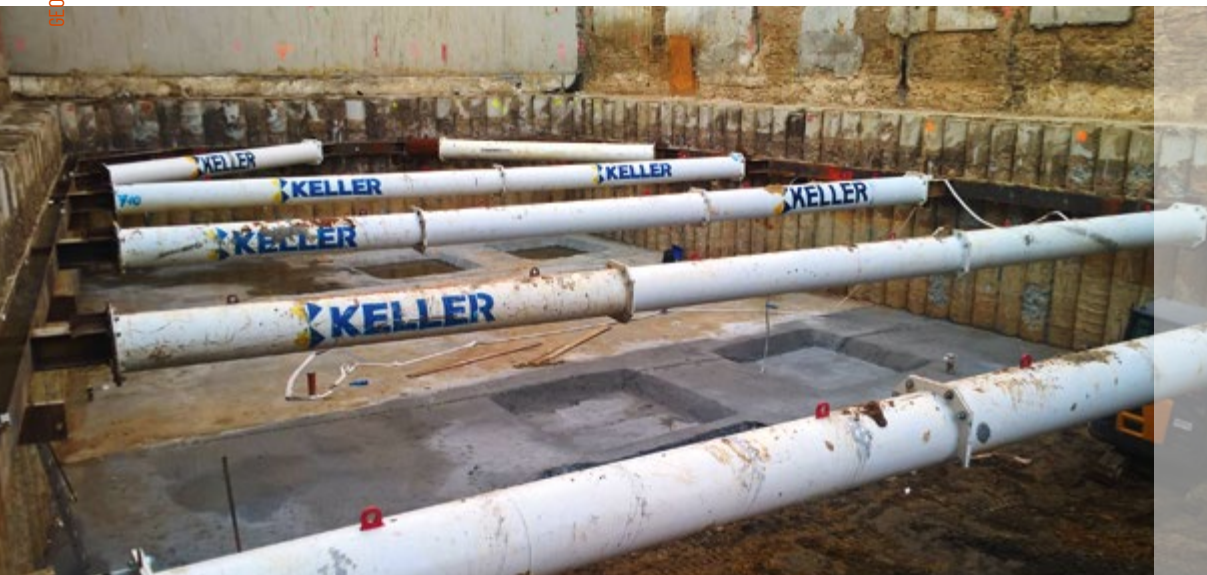
FOT. 4. | Rozpierzana palisada VDW 610 mm. Etap realizacji części podziemnej obiektu.
