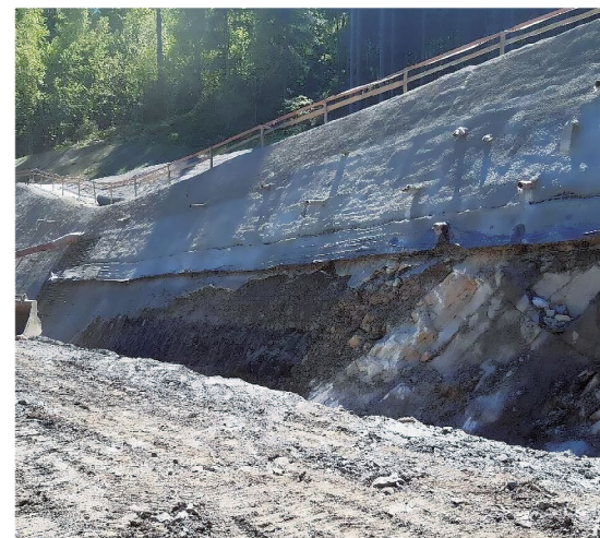
FOT. 10. | Widoczna strefa uskokowa podczas trwających prac
