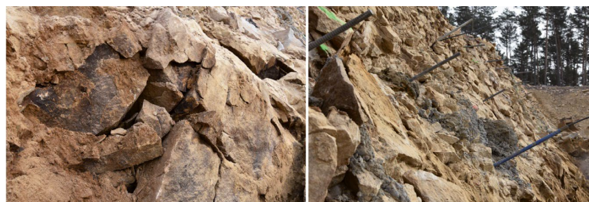
FOT. 2-3. | Stan odkopanego górotworu – portal TD-1 południe
