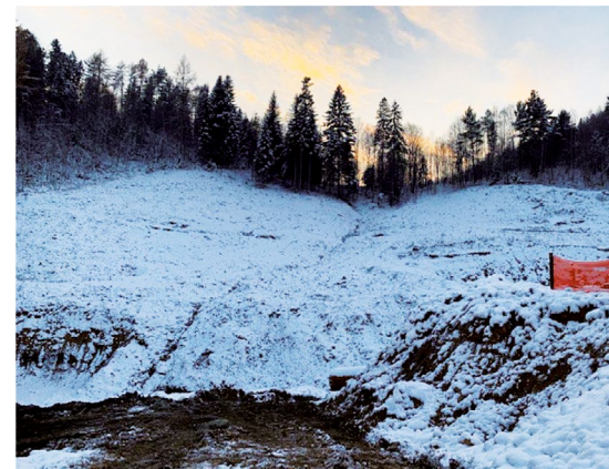
FOT. 9. | Teren przed wykonaniem portalu TD-1 północ z widocznym jarem/strefą uskokową
