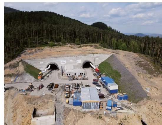
FOT. 4. | Wykonany portal TD-1 południe
