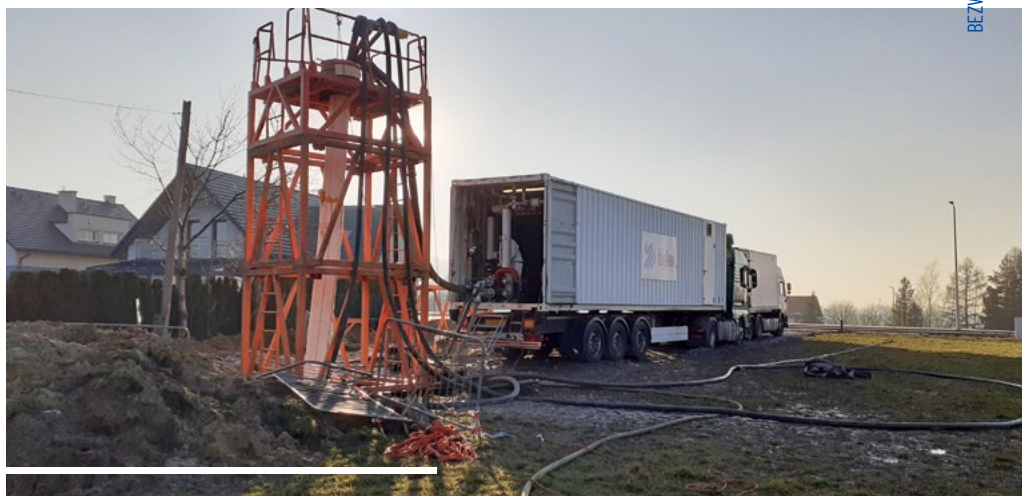
FOT. 3. | Instalacja rękawa POLiner Hydro Glass
