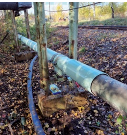
FOT. 2. | W Ostrawie zastosowano Primus Line® do renowacji niez izolowanego nadziemnego rurociągu stalowego
