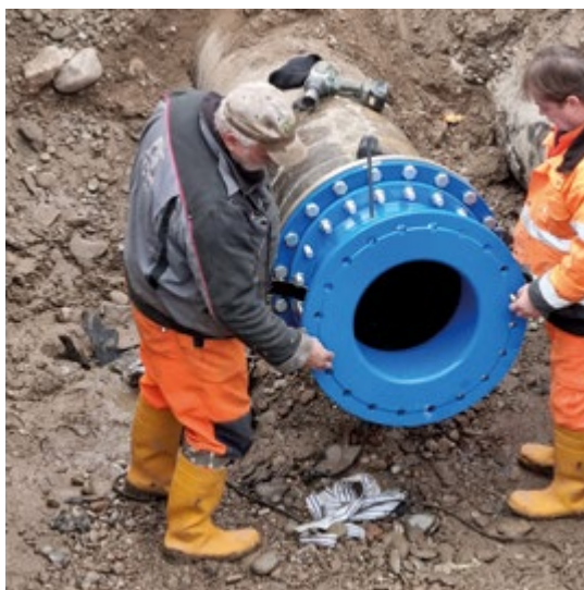
FOT. 2. | W Ostrawie zastosowano Primus Line® do renowacji niez izolowanego nadziemnego rurociągu stalowego
