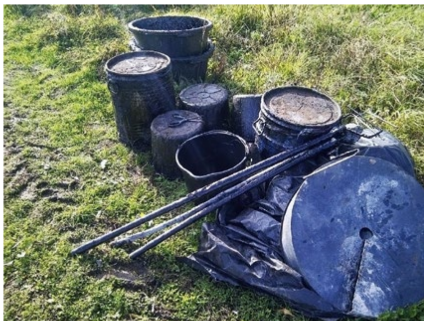
FOT. 1. | Materiały i sprzęt używany do nakładania laminatu na rury przewodowe na placu budowy
