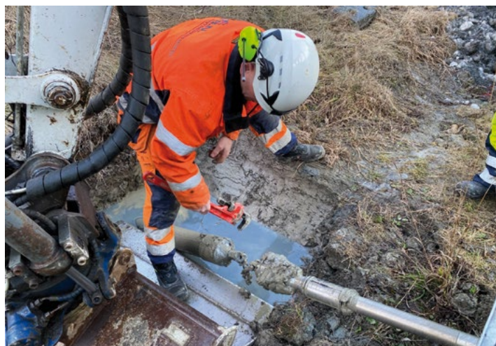
FOT. 5. | Rozwiercanie i wyciąganie rur w miejscu 2 wiercenia (długość 34 m). Demontaż rozwiertaka i uchwytu
