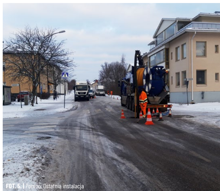
FOT. 4. | Porvoo. Rahataukatu. Ostatnia instalacja
