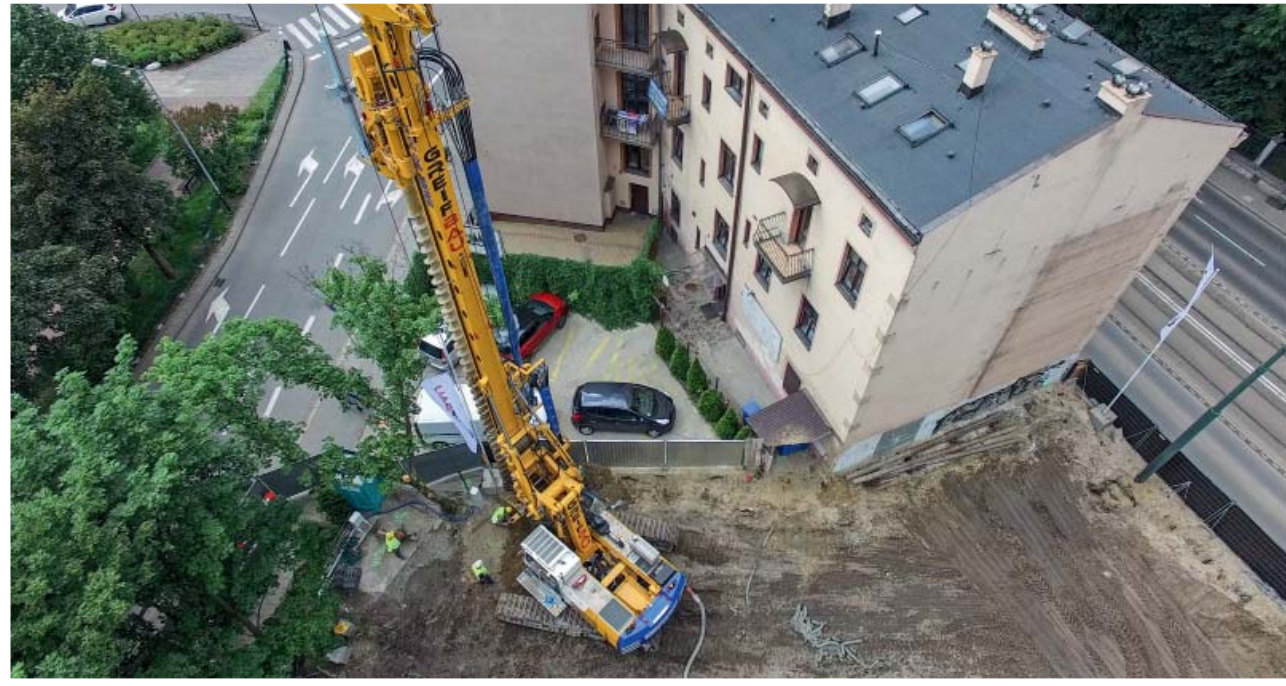
FOT. 1, 2. Plac budowy przy ul. Daszyńskiego/ Grzegorzewska 11, Kraków
