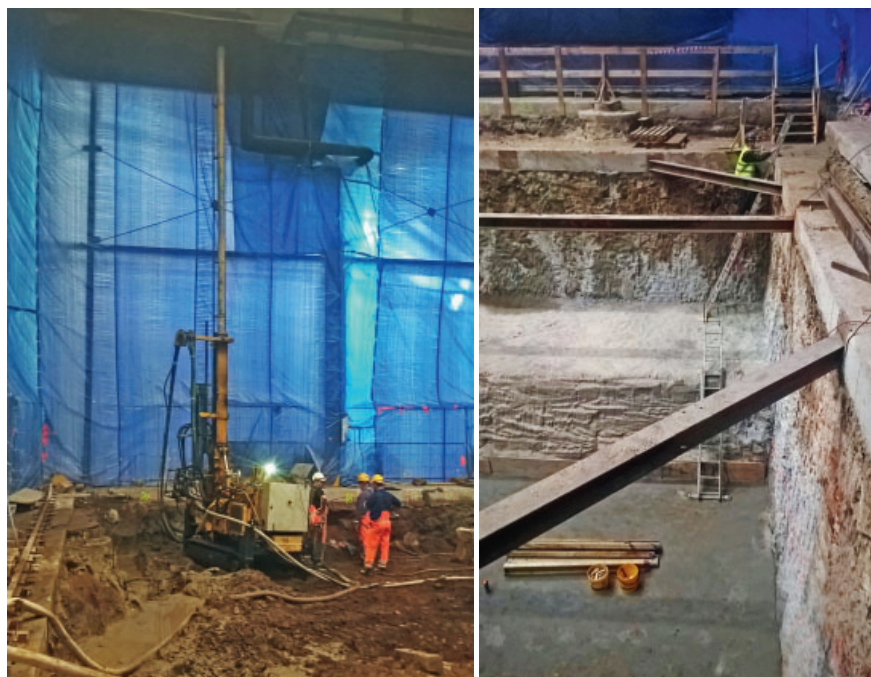
FOT. 1. Wykonanie palisady wewnątrz hali (za niebieską osłoną trwa produkcja zakładu)
