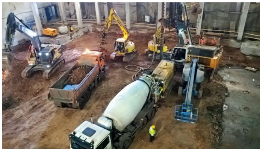
FOT. 3. Duża ilość sprzętu w hali: od lewej koparka do załadunku urobku, wywrotka, koparka z manipulatorem do montażu świda, koparka do odbioru urobku, pompa do betonu i betonmieszarka, wiertnica, podnośnik koszowy do obsługi montażu wstawki świda
