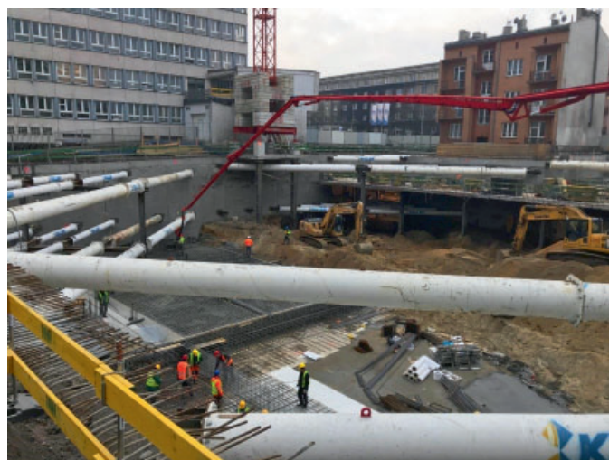
FOT. 4. Betonowanie działki płyty fundamentowej
