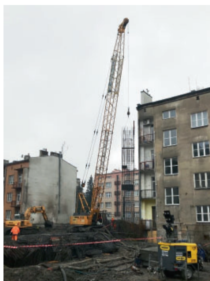
FOT. 1. Plac budowy podczas wykonywania ścian szczelinowych
