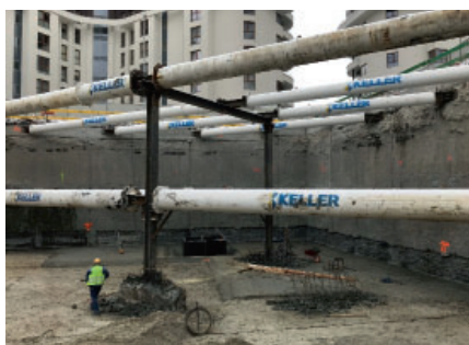
FOT. 2. Wykop do rzędnych docelowych pod stropem rozporowym
