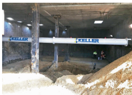
FOT. 3. Wykop do rzędnych docelowych od strony ul. Kriegera
