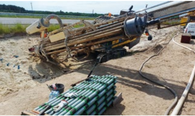
FOT. 4. | Wiercenie otworów iniekcyjnych FOT. 5. | Zaplecze budowy
