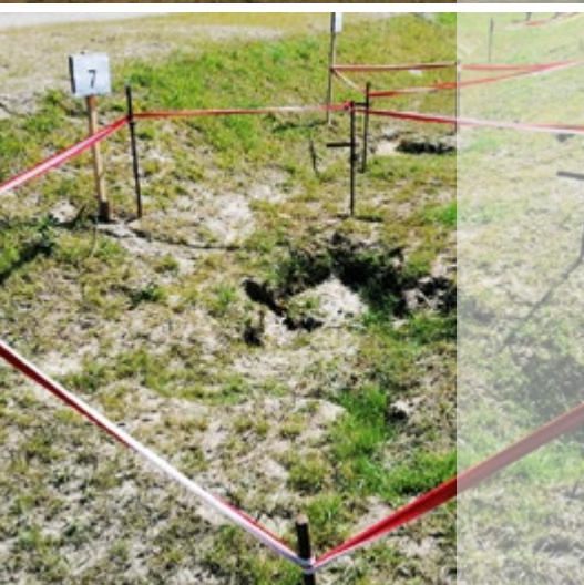
FOT. 1. | Powstałe w okresie wiosenno-zimowym 2021 typowe formy krasowe na jednym z odcinków drogi ekspresowej S19
