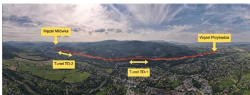
FOT. 2. | Przebieg odcinka drogi ekspresowej S1. Fot. Keller Polska
