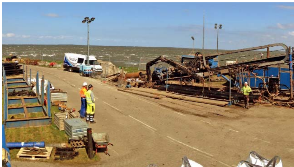
FOT. 2. Rurociąg po zakończeniu wciągania po stronie Texel
