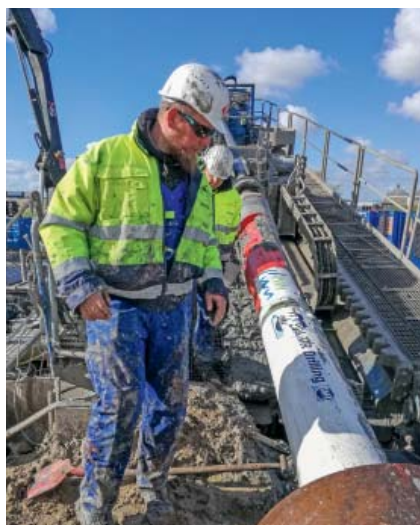
FOT. 2. Rurociąg po zakończeniu wciągania po stronie Texel
