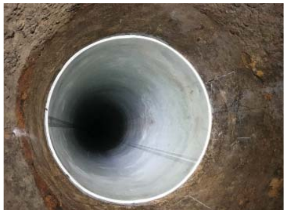
FOT. 1. The SAERTEX-LINER Pressure instalowany w mieście Piacenza we Włoszech RYS. 2. Ustawienie testowe zgodne z ISO 15306 w IMA Dresden
