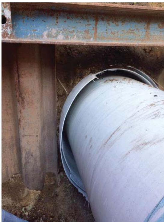
FOT. 1. Konsekwencja braku przyczepności laminatu po jego uszkodzeniu w otworze wiertniczym
