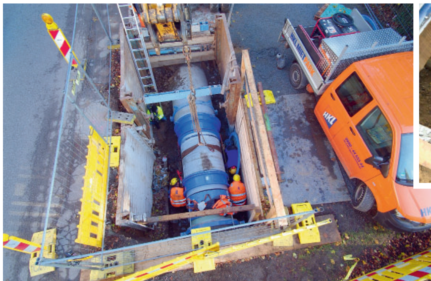
FOT. 3. Ponowne łączenie wyremontowanych odcinków rurociągu
