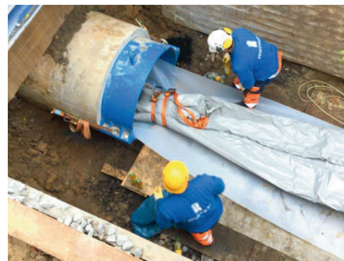
FOT. 3. Ponowne łączenie wyremontowanych odcinków rurociągu
