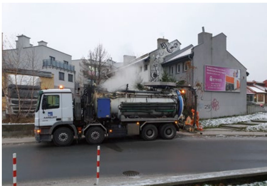
FOT. 7. | Hydrodynamiczne czyszczenie kanalizacji w ul. Zamkowej
